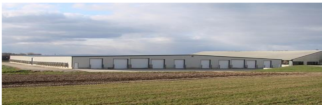
شکل شماره ۱۶. نمایی از یک سالن فری استال با تھویه عرضی که فن ها بر روی دیوار طولی سالن نصب شده اند.
